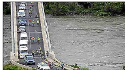
► L'Handitour sur le pont du barrage de Caramany.
